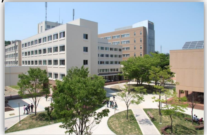
耐震化・設備改修工事や太陽光パネル 取付を行った長岡技大の建物
