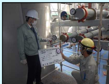
共同溝内の配管検査
