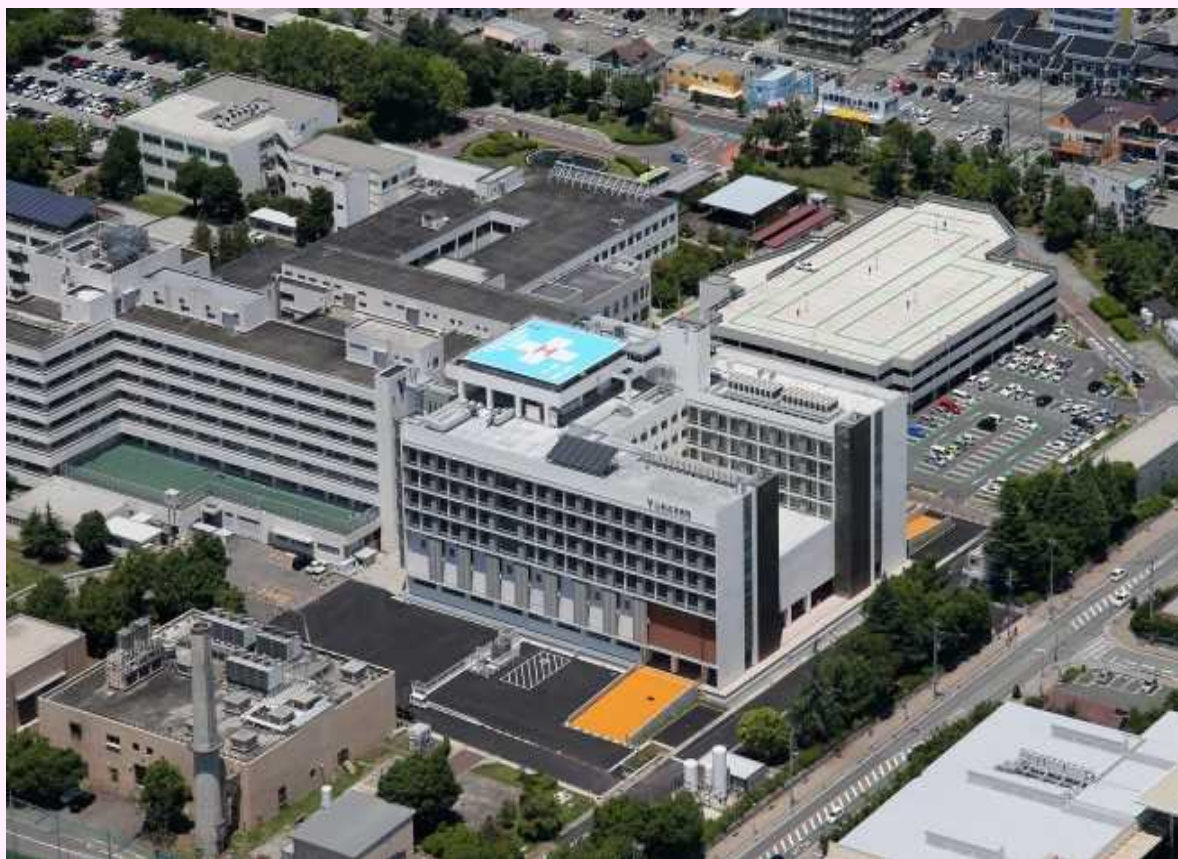
附属病院病棟Ⅰ完成写真 (平成28年1月より稼働中) 【医学部キャンパス】
