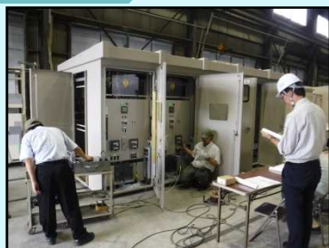
電気設備(キュービクル)検査
